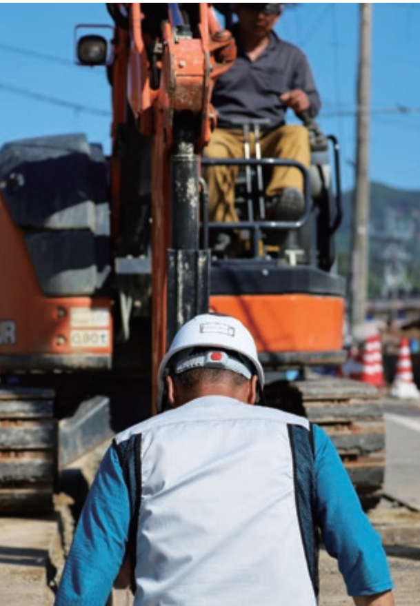
焼け野原になった輪島朝市の近くで行われていた水道管工事の様子。朝市通りでは6月5日に建物の公費解体が始まった
